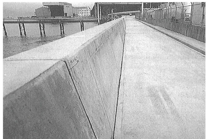
▲護岸目地に使用
